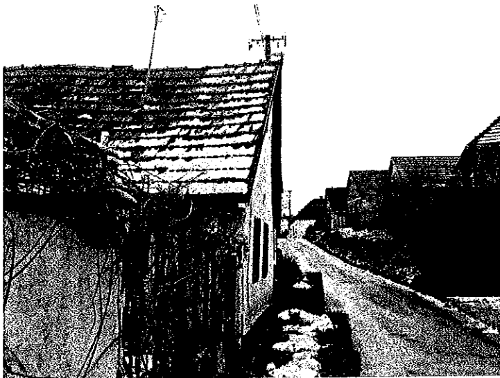
Az oromfal az utca felé dől, a tető erősen hullámos.
